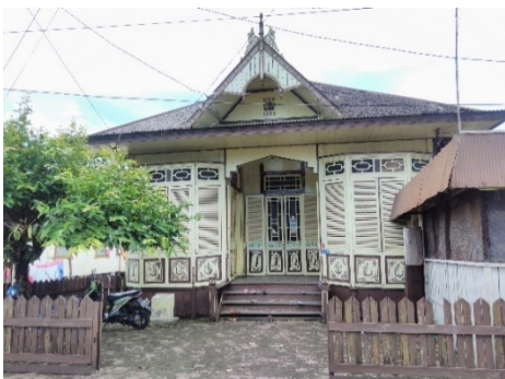
Gambar 1. Rumah bangun Gudang Tampak Depan
